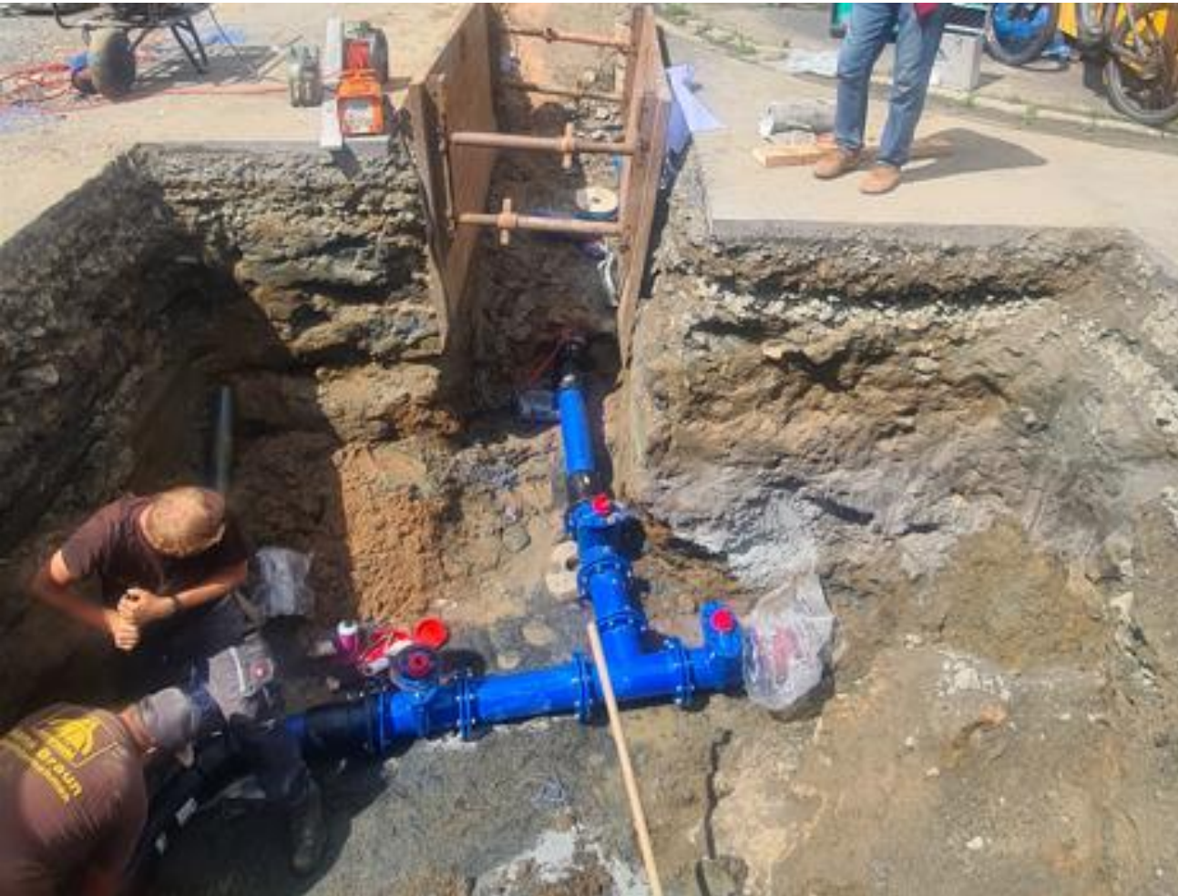
Kanalсанierung - Austausch eines Abschnitts im Marterlweg
