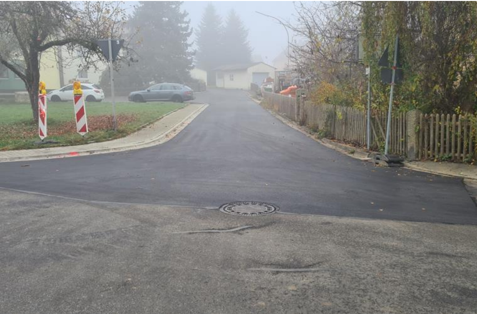
Kanalсанierung (Asphaltierung in Reuth)
