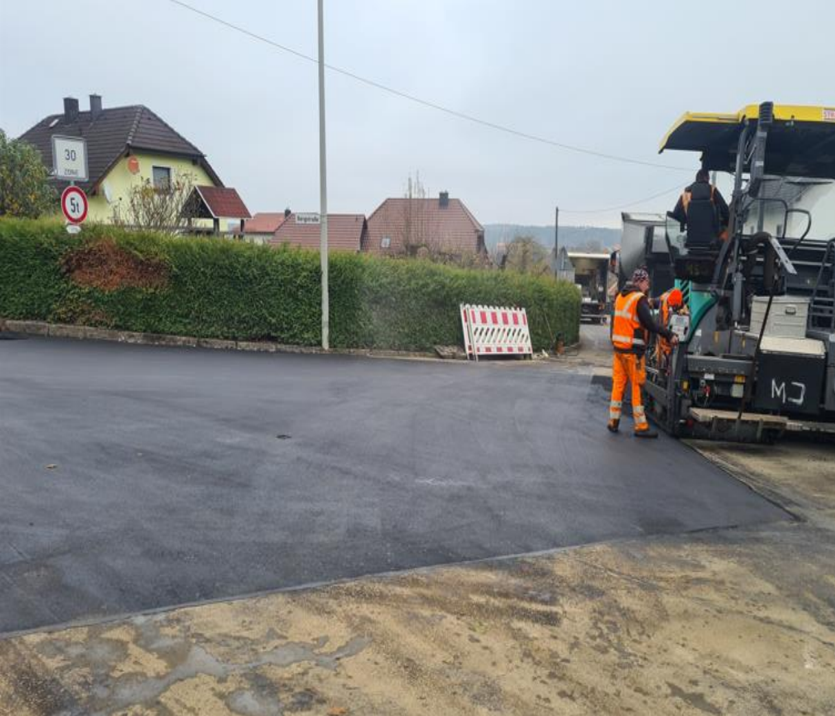
Kanalsanierung Letten (Bergstraße)
