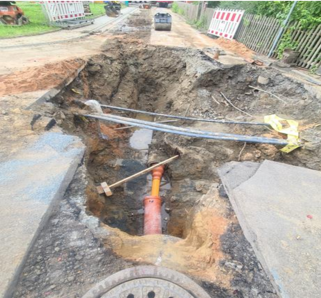
Kanalsanierung - Austausch eines Abschnitts im Marterlweg
