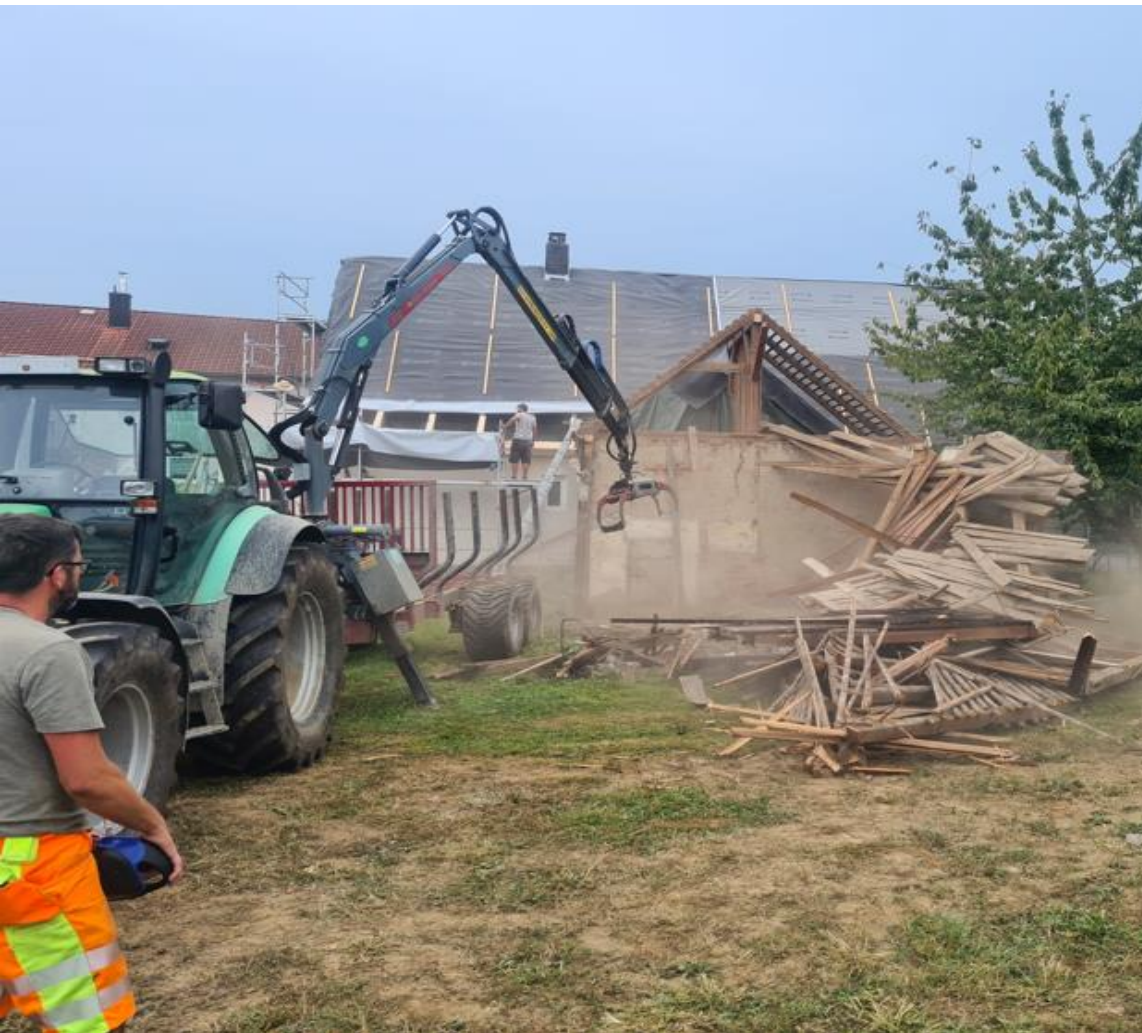
Abbruch Anbau am „Arbeiterhaus“
