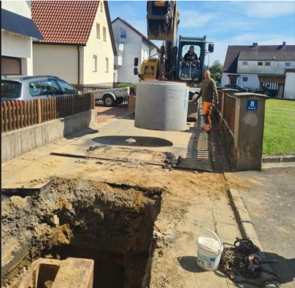
Kanalsanierung - Austausch eines Abschnitts im Marterlweg
