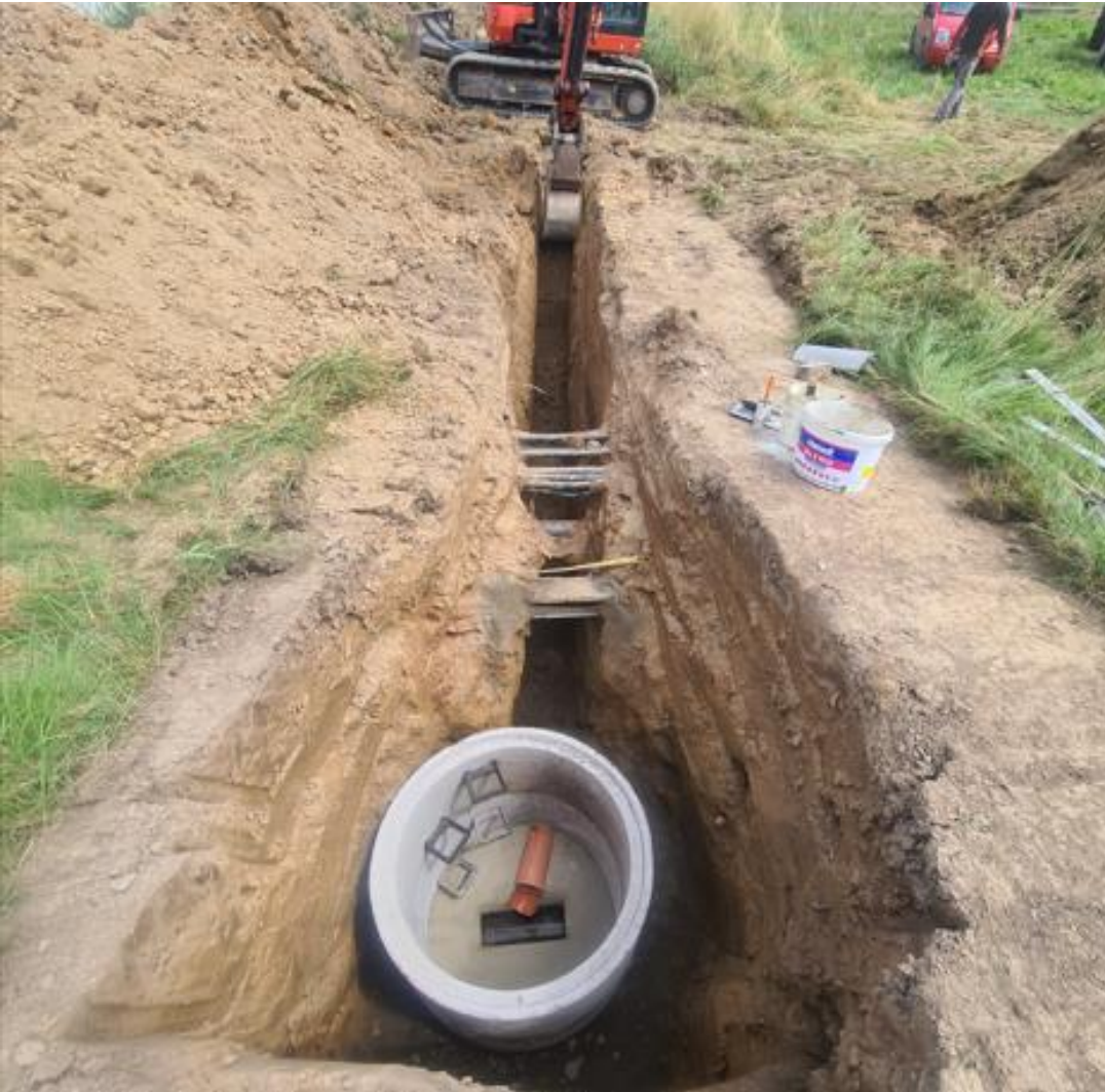
Herstellung Kanalanschluss im Gewerbegebiet
