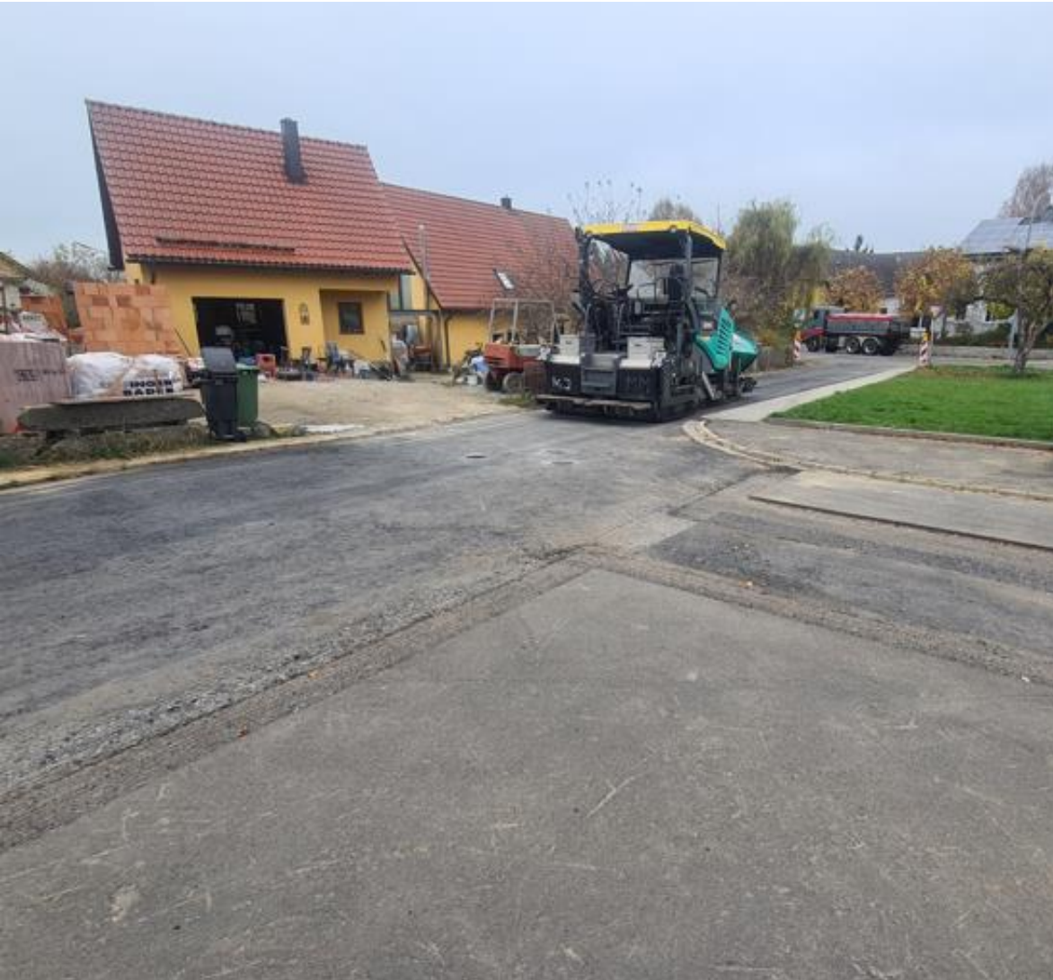
Kanalсанierung (Asphaltierung in Reuth)
