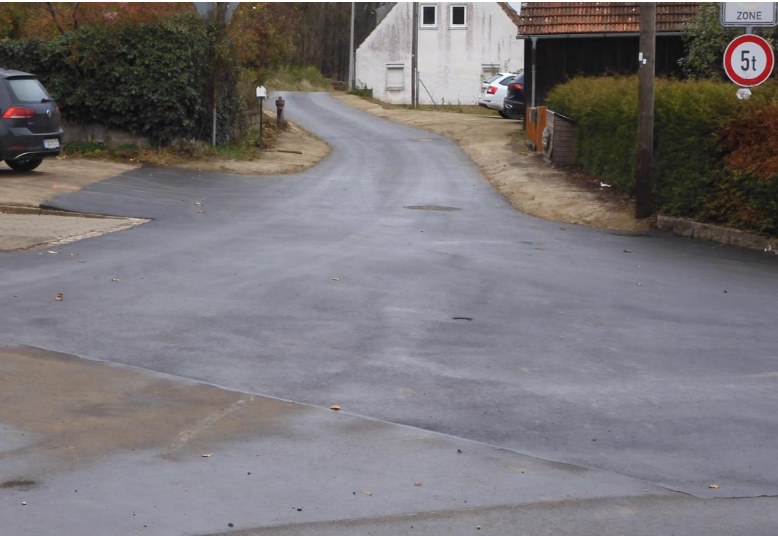
Kanalsanierung (Asphaltierung in Letten)
