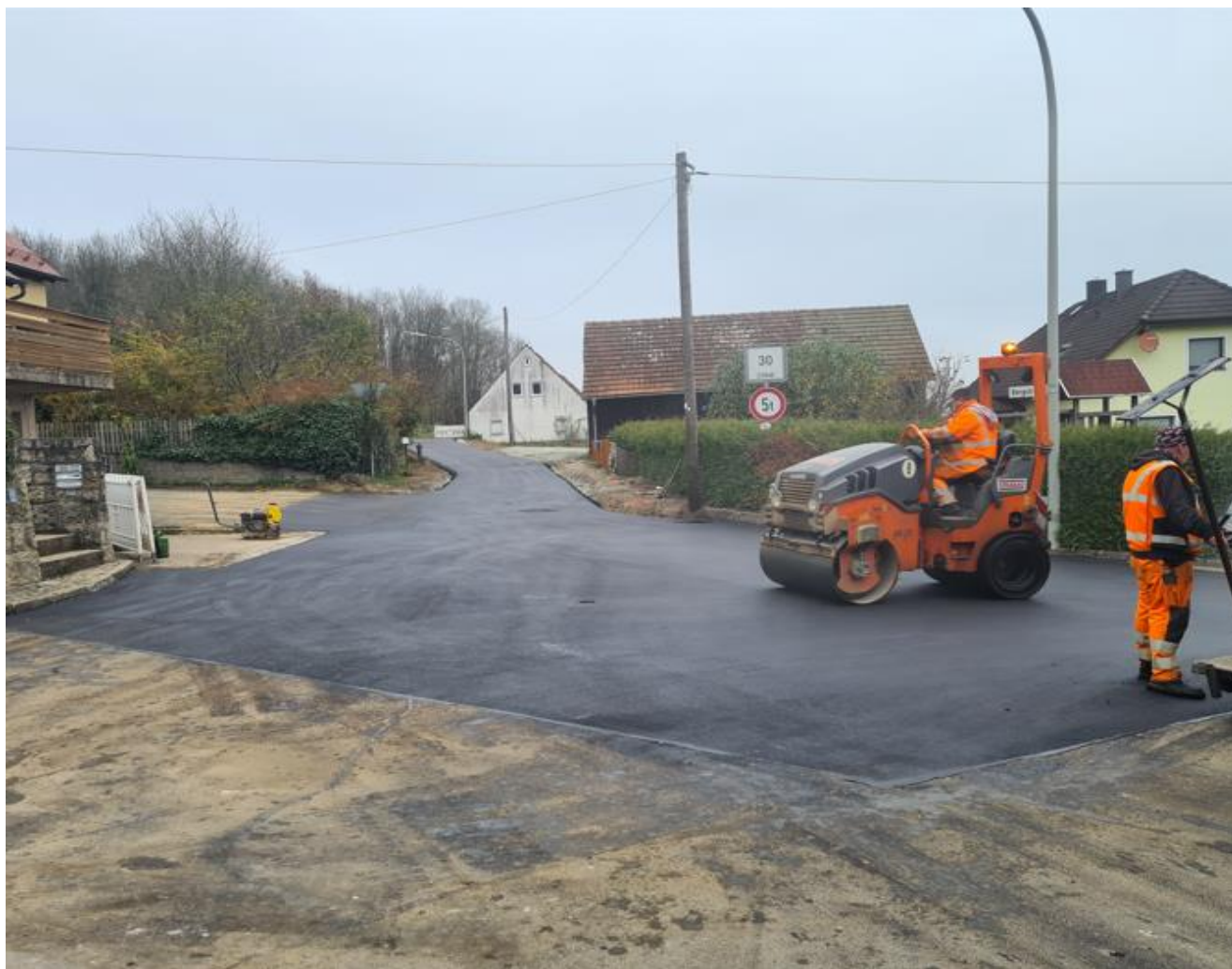
Kanalsanierung (Asphaltierung in Letten)
