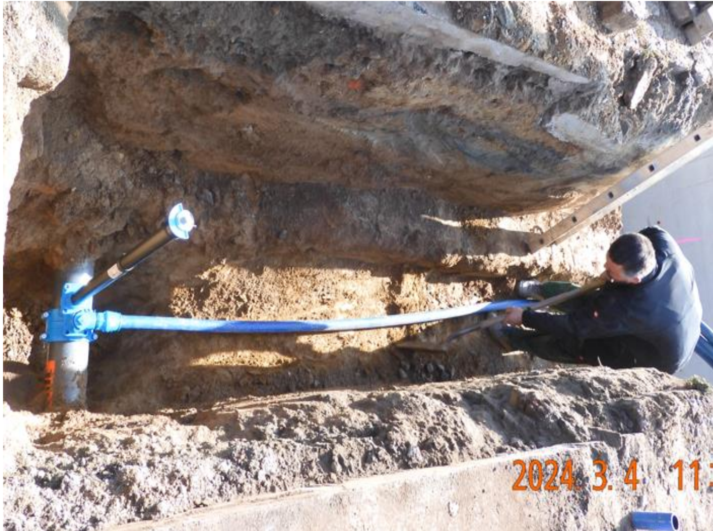
Metzgerei-Gasthof-Dorfladen – Herstellung WL-Anschluss
